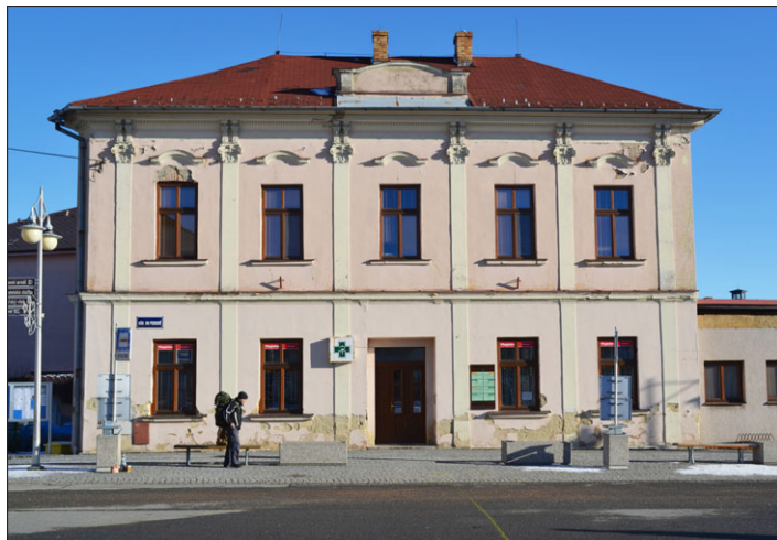
Zdravotní středisko před rekonstrukcí a po rekonstrukci.
