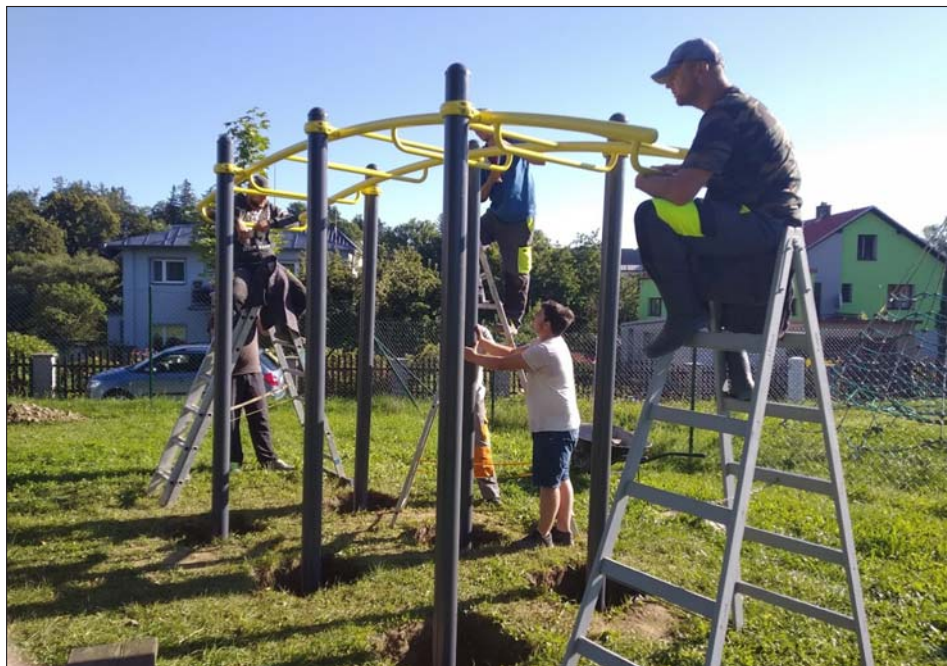
Instalace prvků workoutového hřiště
