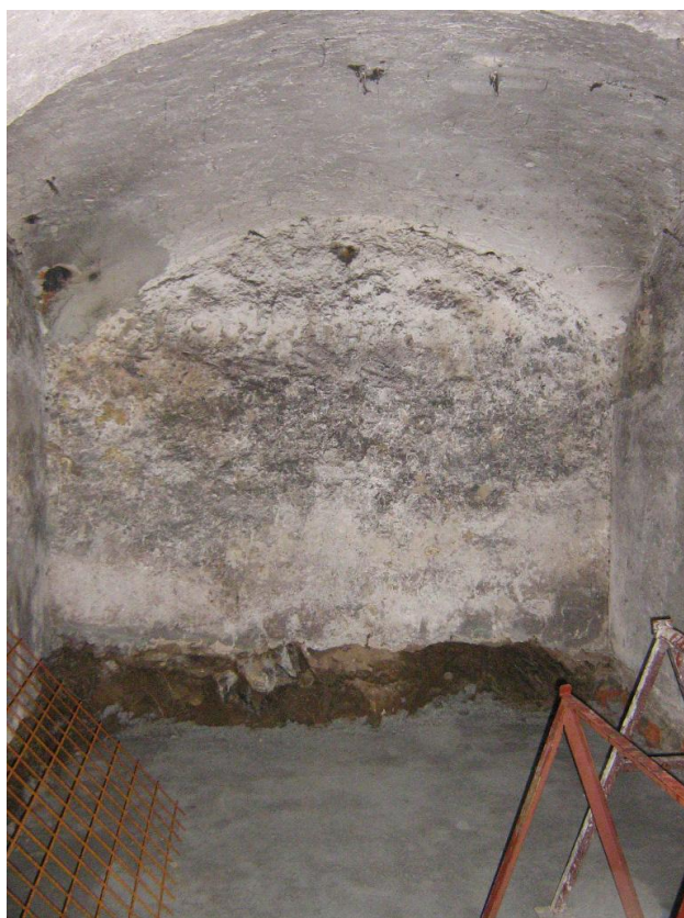
Září 2009 – expoziční prostory - sklep (1.PP)
